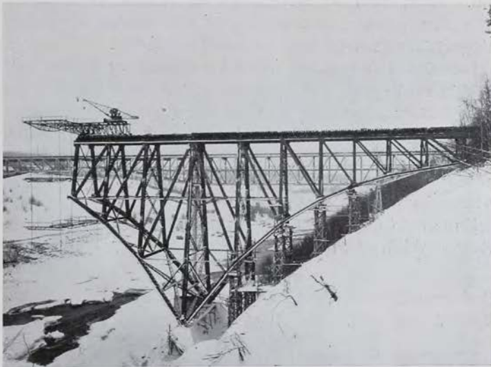
Fig. 46. Södra båghalvan av Forsmobron under uppsättning.
