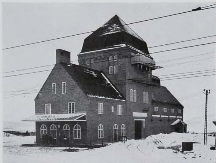
Fig. 25. Stationshus med transformatorstation i Torneträsk.
