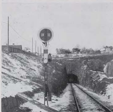
Fig. 85. Försignal med vinge.
