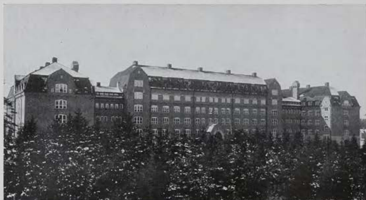
Fig. 68. Kungl Järnvägsstyrelsens kontorsbyggnad vid Tomtebodå.
