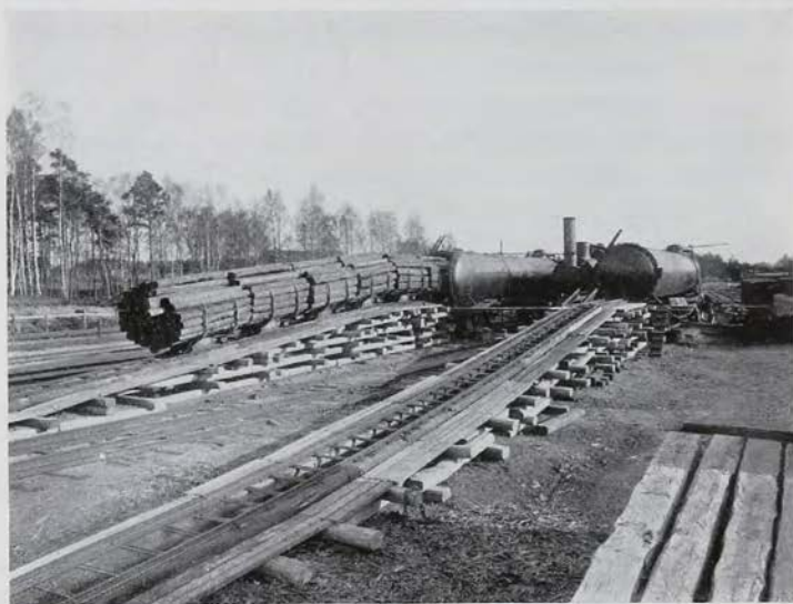
Fig. 41. Statens järnvägars större slipersimpregneringsapparat.
