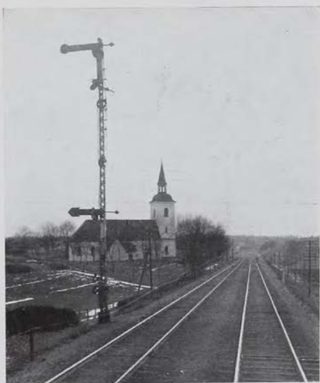
Fig. 84. Semafor med genomfartsvinge.
