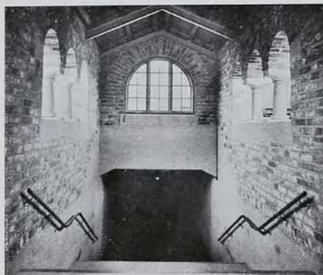
Fig. 62. Trapphus till persontunnel i Nyköping.
