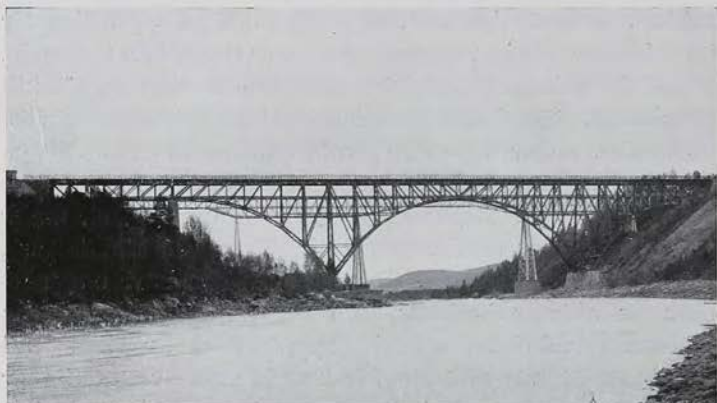
Fig. 45. Nya Forsmobron över Ångermanälven. Omedelbart bakom synes den gamla bron.
