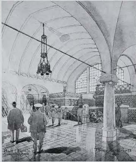
Fig. 64. Eslöfs nya stationshall.
