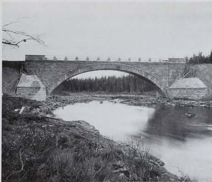
Fig. 52. Fläsjöbron i färdigt skick.
