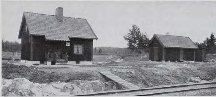
Fig. 67. Nyuppförda banvaktstugan nr 362 å linjen Järna—Hölö.
