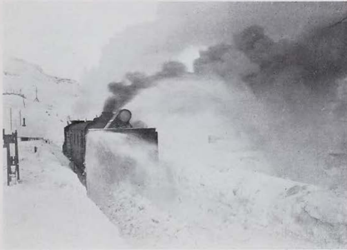
Fig. 90. Roterande snöplog i arbete.
