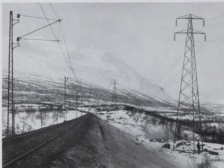
Fig. 26. Överföringsledning och kontaktledning å linjen Kiruna—Riksgränsen.
