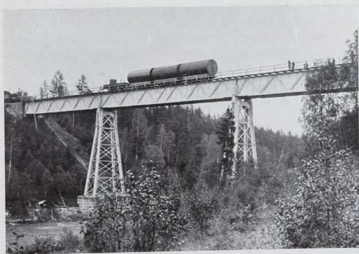
Fig. 22. Belastningsprov med användande av vagnar litt. Q9.
