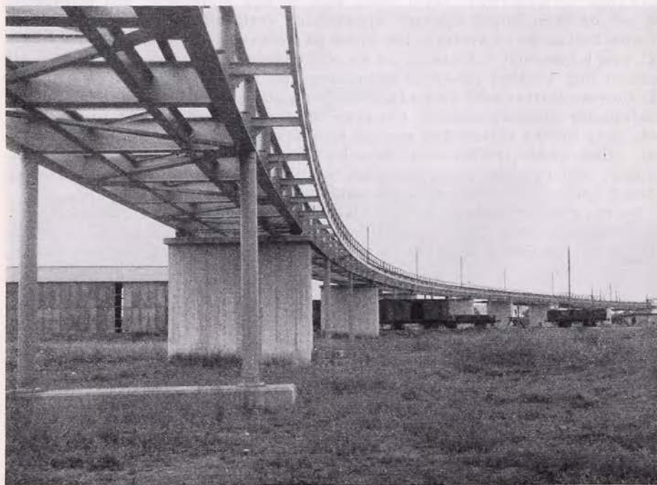
Bild 1. Viadukt med cirkelformigt krökta huvudbalkar.
