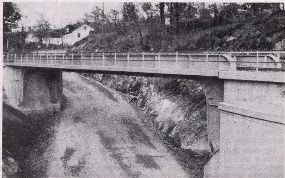
Bild 1. Viskafors. Nya vägporten.
