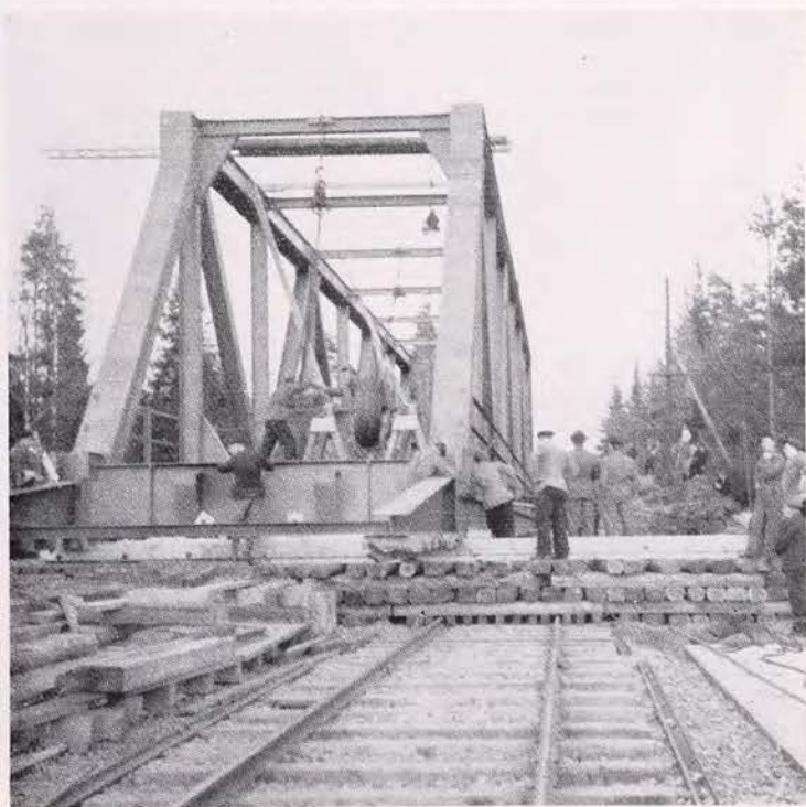
Bro över Göta älv vid Vargön. Nya stålöverbyggnaden under sidoförhållning.
