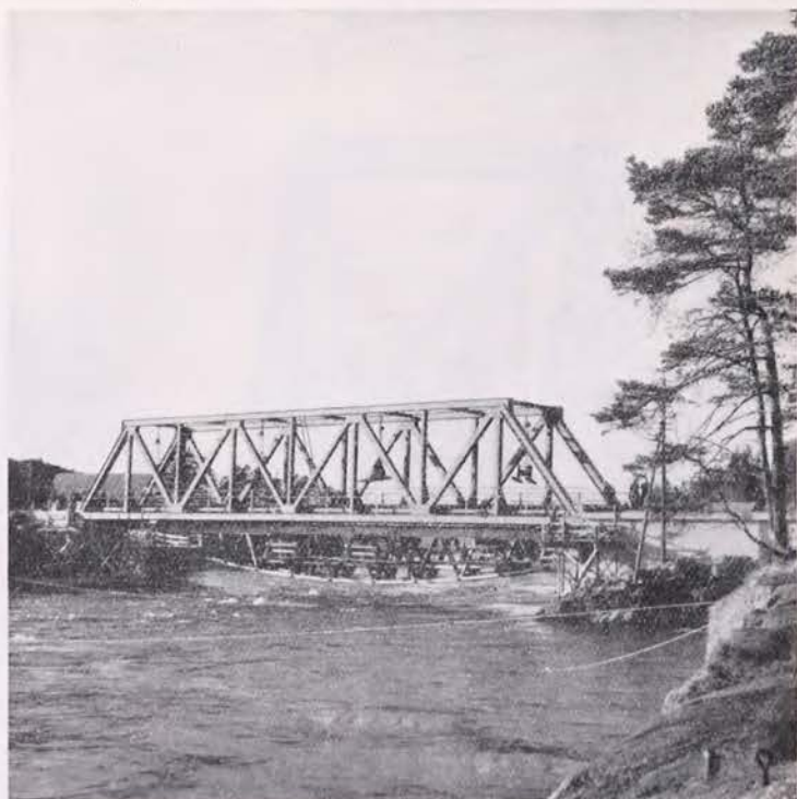
Bro över Göta älv vid Vargön. De båda stålöverbyggnaderna efter nedsänkningens avslutande.
