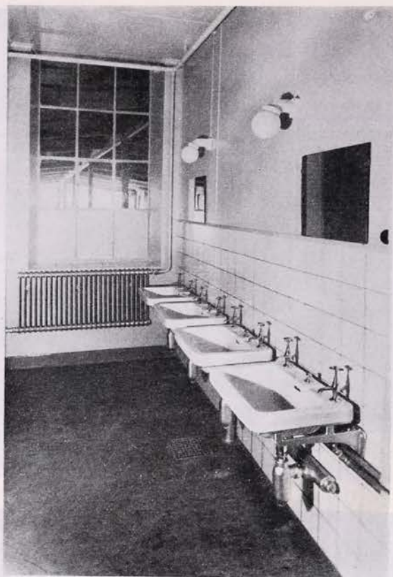
Malmö. Tillbyggnad av magasin för ankommande fraktgods. Interiör av tvålrum för personalen
