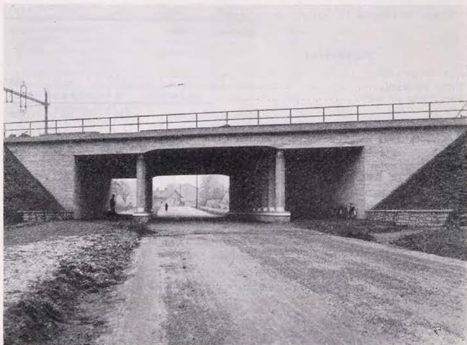
Bild 1. Vägport vid Mörke i färdigt skick.
