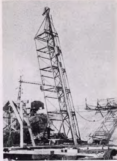
Bild 2. Vägport vid Mörke. Nedslagning av 18 m långa betongpålar.
