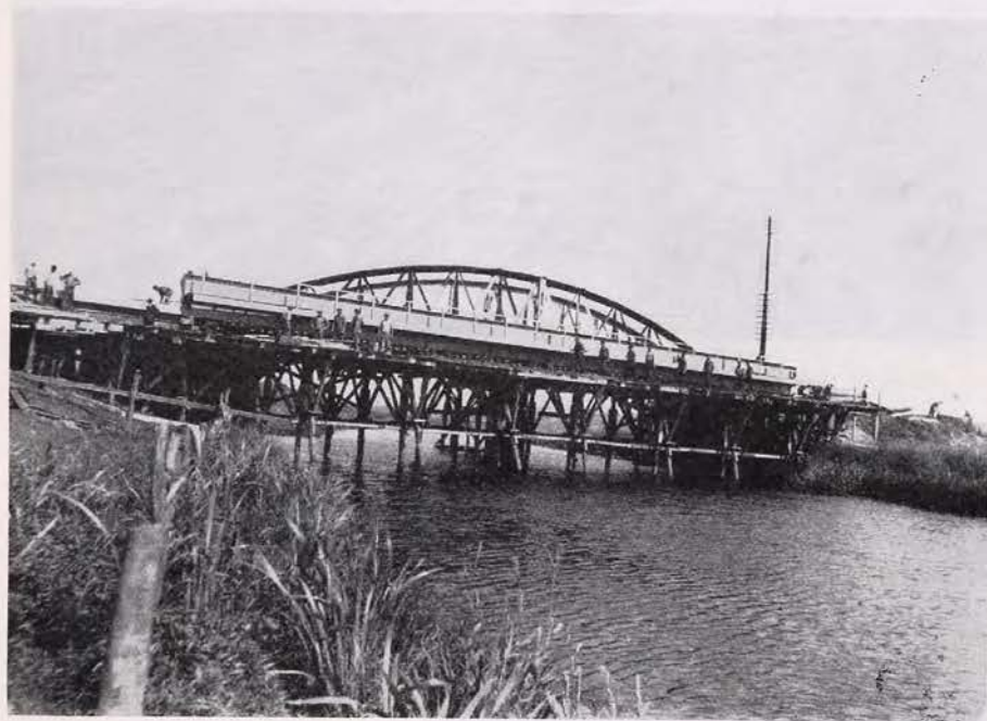
Bild 1. Bro över Rönne å. Den nya stålöverbyggnaden färdigmonterad på ställning vid sidan om den gamla parabelbron.
