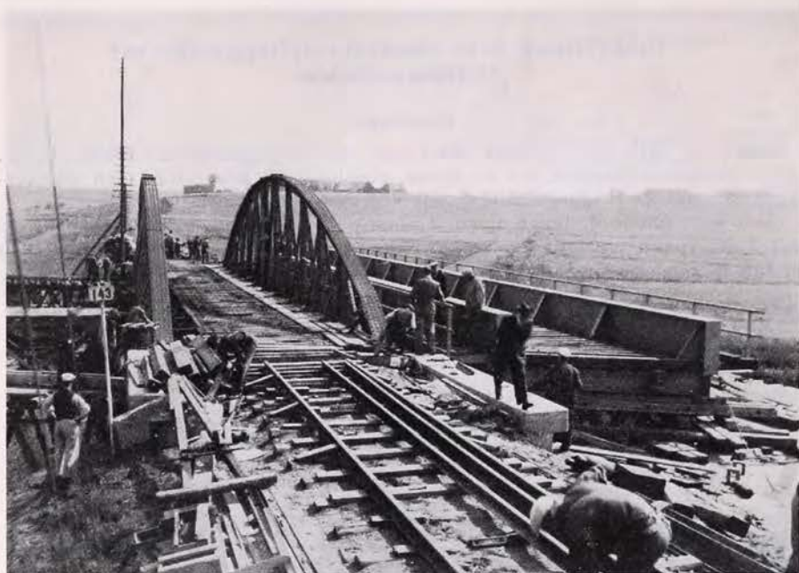
Bild 2. Bro över Rönne å. Broöverbyggnaderna upplagda på slädar i och för sidoförhalning. Spåret brutet.
