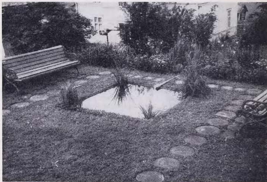
Damm med träväggar. Även gångplattorna äro av trä.
