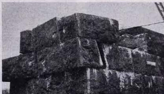
Bild 6. Pelaren närmast vägporten efter första sprängningen.
