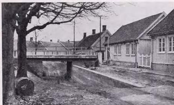
Bild 2. Falkenberg, gångtunneln i Storgatan.
